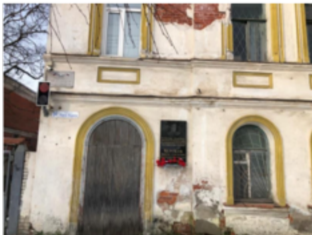
Здание, в котором жил В.С. Чероков
